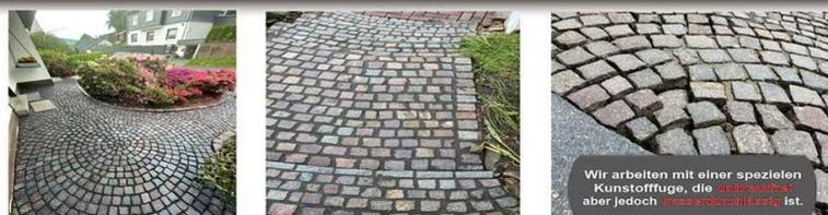
Wir arbeiten mit einer speziellen **Kunststofffüge**, die **unwuchsresistent** ist, aber jedoch **wasserdurchlässig** ist.
