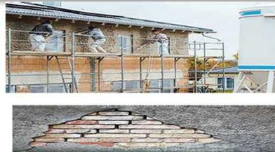
Wenn der alte Putz reißt oder bröckelt, sollte der Hausbesitzer nicht lange mit einer Sanierung warten. Risse und Löcher in der Fassade sind nicht nur unschön, sie können langfristig schwere Schäden zur Folge haben, weil der Außenputz das Mauerwerk nicht mehr ausreichend vor Feuchtigkeit und Umwelteinflüssen schützen kann. Aber keine Sorge, um dabei höhere Kosten zu vermeiden, lohnt es sich einen Experten von uns zu rufen und den Schaden langfristig zu beheben.
